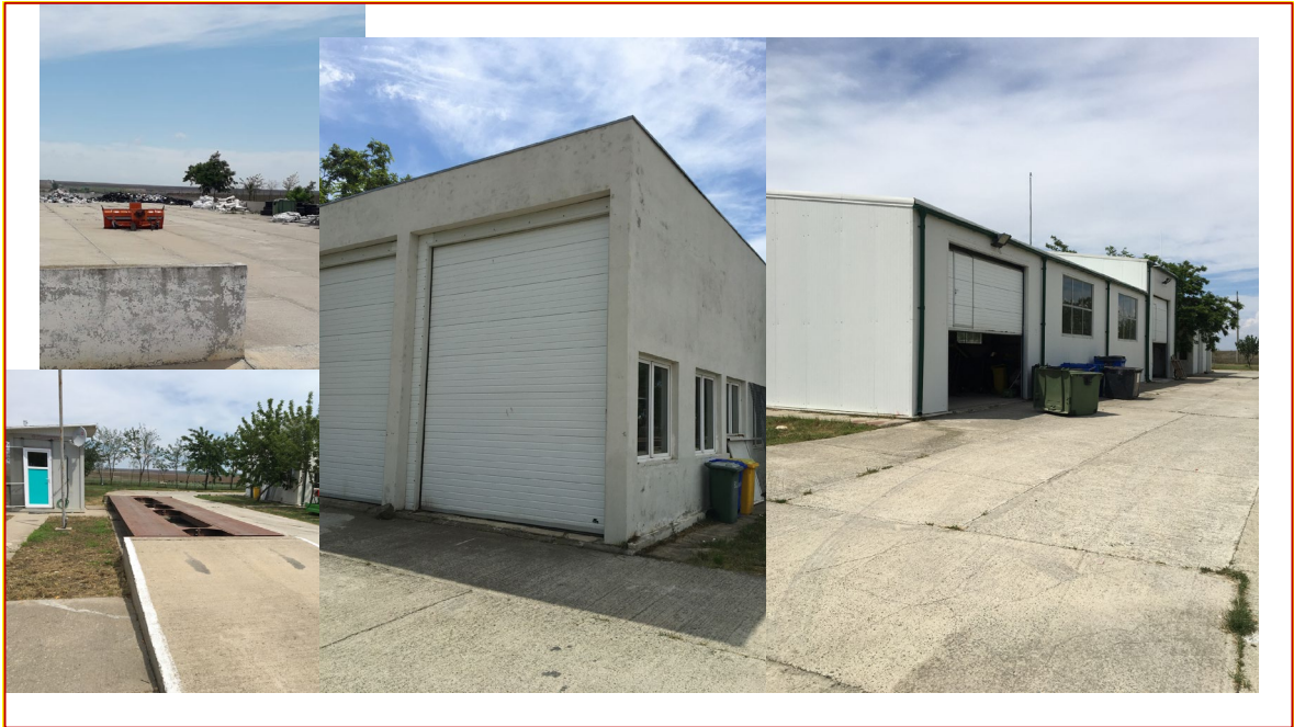
Figura 4-3: Infrastructura stației de sortare Corbu
