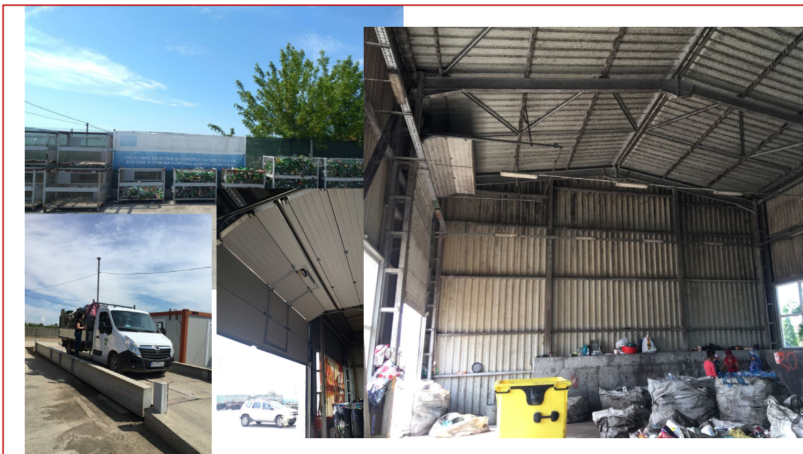
Figura 4-5: Infrastructura stației de sortare Cumpăna
