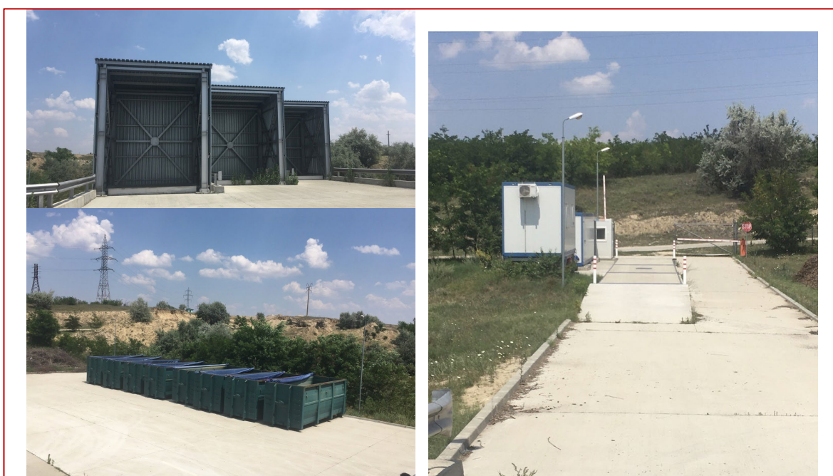
Figura 4-2: Infrastructura stației de transfer Hârșova
