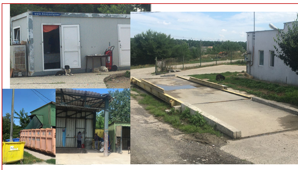
Figura 4-8: Echipamente tehnologice stație de sortare Cernavodă
